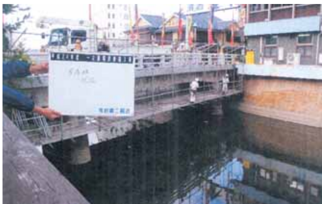
一之橋修繕工事
