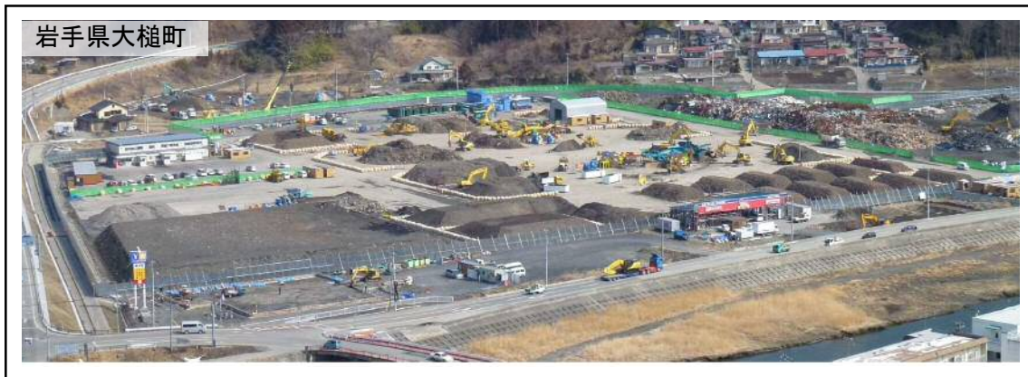
図 2-6-(10)-3 二次仮置場の例
