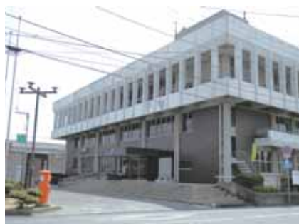
町役場庁舎 耐震診断へ
