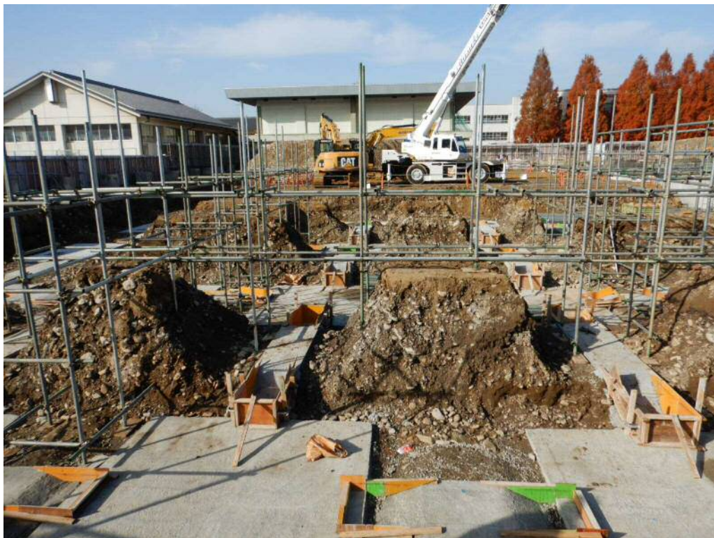
体育館棟の工事が始まりました。
