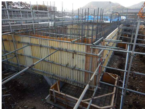
校舎棟のK-3工区の様子です。 型枠を設置して、コンクリート打設まで まもなくです。
