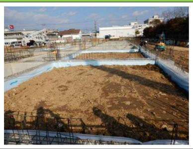
基礎コンクリートを打設した後は、養生期間が経過すると、型枠を脱型して、掘削した土を埋め戻していきます。
