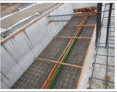
K-1・2工区は地下 ピットの土間コンクリ ートを打設していま す。地下には消火水槽 を設置したり、地下ピット内には電気や通信 などのケーブルなどを 敷設します。
