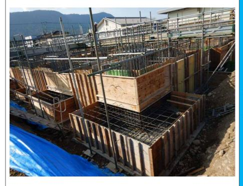
コンクリート打設前の T-1工区です。昨年 末には基礎コンクリー トを打設し、現在は型 枠を脱型しています。
