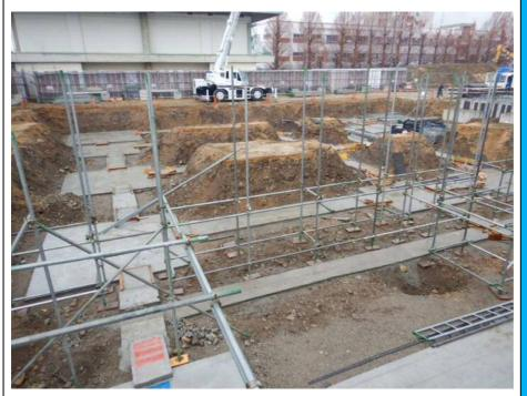
T-2・3工区は掘削 工事が終了し、基礎配 筋工事へと進んでいき ます。
