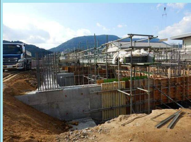
体育館棟の半工区は基礎コンクリートを打設し、養生した後に型枠を脱型し、現在は土を埋め戻しています。当初に掘削した土は高く積み上げられていましたが、埋め戻しにより、段々と山が崩され、低くなってきています。
