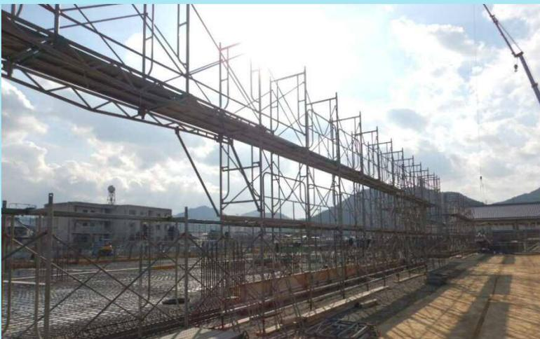
校舎棟は現在、1階の床となる土間配筋を行っています。格子状に鉄筋が生まれ、全面に張り巡らされています。配筋工事が終わるとコンクリートの打設へと進んでいきます。
