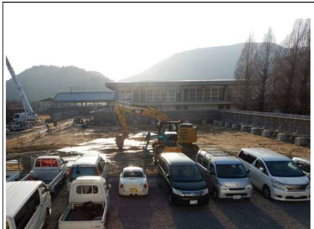
基礎工事のために掘削した土は、基礎工事が完了し、埋め戻されました。高く積まれた土の山の姿は、影も形もなくなりました。
