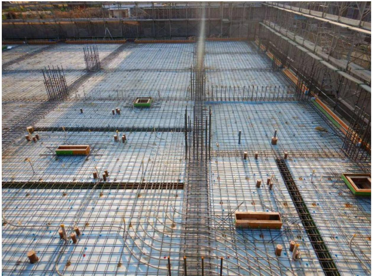
体育館棟の1階床の配筋の様子です。現在はコンクリート打設が完了し、柱や壁の配筋や型枠工事を行っています。
