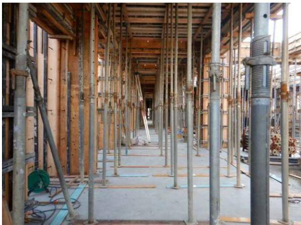
校舎棟の廊下の様子です。柱や壁、2階床や梁となる型枠が組み、型枠を支えている支保工が見えます。新校舎は廊下を挟んで両側に部屋がある、両廊下となります。
