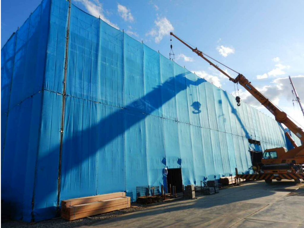
校舎棟は、資材・工具等の飛来・落下防止や周辺への危害防止のために、周囲をメッシュシートで覆っています。
