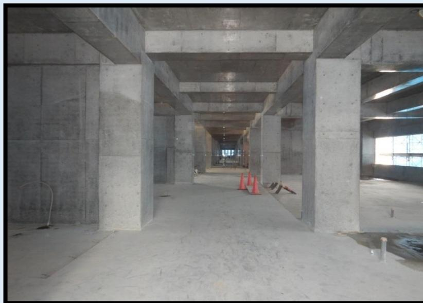
校舎棟の1階の型枠が取り外され、コンクリートが見えるようになりました。写真は廊下東側から撮影したものであり、しっかりとした梁や柱が伺えます。右側（北側）に生徒昇降口や職員室等、左側（南側）に各教室や保健室、校長室などが配置されます。
