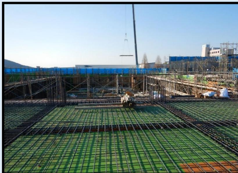
体育館棟2階のコンクリート打設が完了し、3階床の配筋工事を行っています。新しい体育館の2階にはアリーナやステージ、部室、教官室、器具庫などを配置します。3階にはオープンスペースや災害時に対応できるように備蓄庫を設けます。
