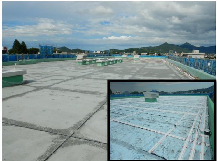
上の写真は校舎棟屋上防水工事施工後の様子です。一見防水工事をしているようには見えませんが、右下の写真のようにコンクリートの下に防水層を設けており、この層により上部からの雨水を防ぐ構造となっております。
