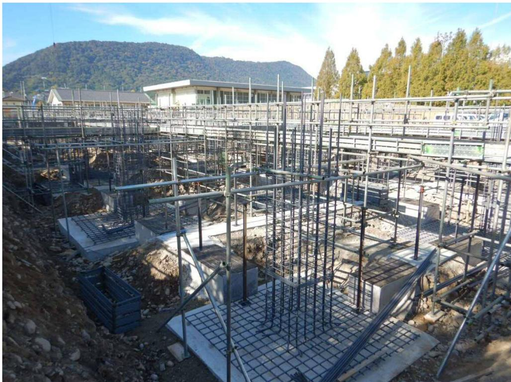
校舎棟は鉄筋を組んで骨組みを作る、基礎配筋工事を行っています。
