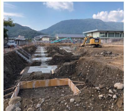
③ 基礎の底面を平らにして作業をしやすいするための捨てコンクリート作業です
