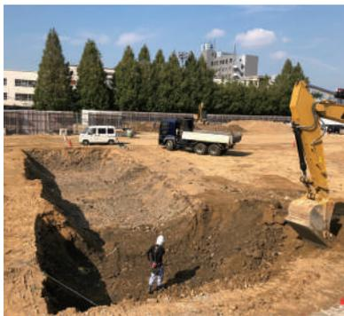
② 基礎や地下構造物を埋設するために掘削を行っています
