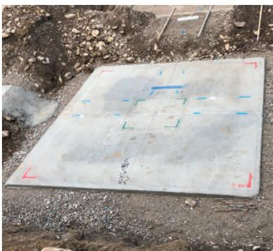
④ 捨てコンクリートに柱や壁の位置を示しています(墨出し)
