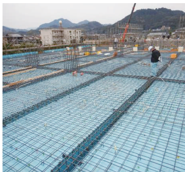
2階床の配筋の様子(校舎棟)
