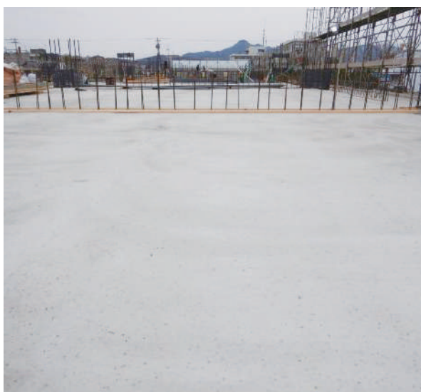
2階床コンクリート打設の様子(校舎棟)
