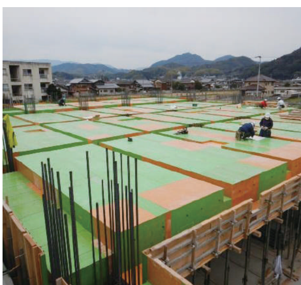
2階床の配筋前の様子(体育館棟)
