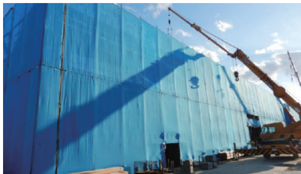
安全設備設置状況(校舎棟)
