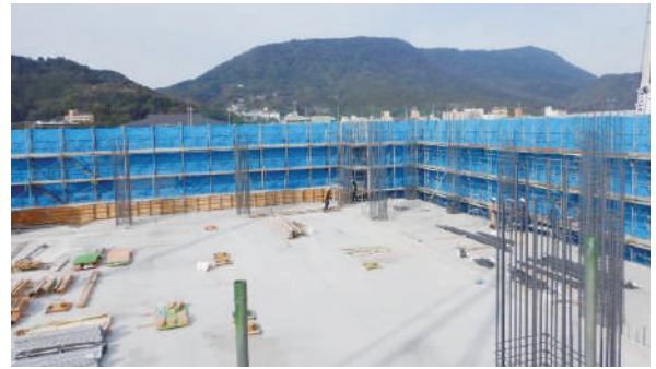
2階の柱、壁の配筋の様子(体育館棟)
