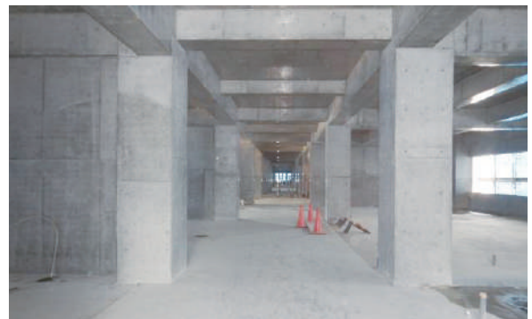
1階型枠取り外し後の様子(校舎棟)
