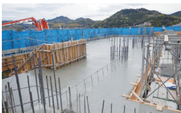
3階床コンクリート打設後の様子(体育館棟)
