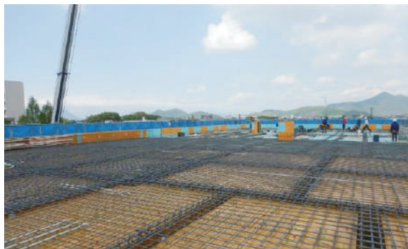
屋上のコンクリート打設前の様子(校舎棟)
