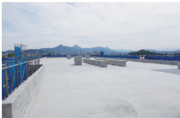
屋上の機械基礎コンクリート打設後の様子(校舎棟)
