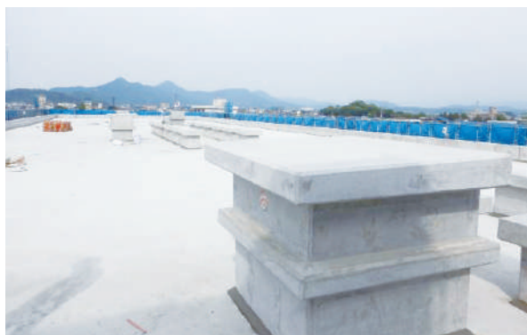
屋上機械基礎コンクリート打設完了(校舎棟)
