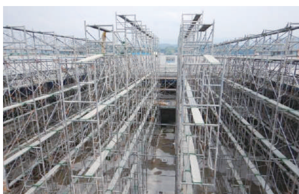
アリーナ内部足場組立状況(体育館棟)
