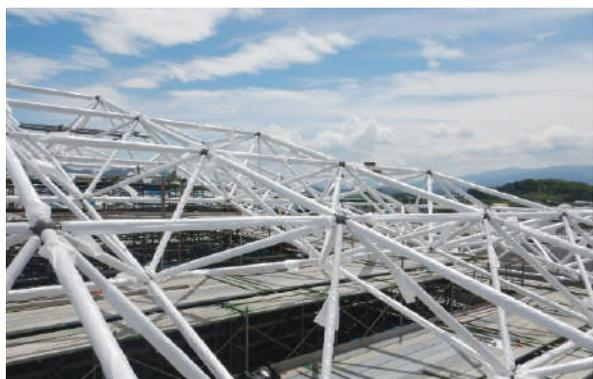
鉄骨屋根トラス施工様子(体育館棟)
