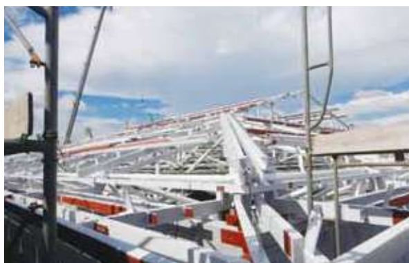
鉄骨トラス母屋受材施工の様子(体育館棟)
