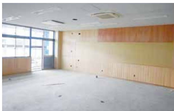
内装工事施工の様子(校舎棟)
