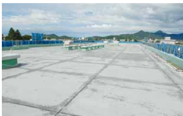
屋上防水工事完了後の様子(校舎棟)
