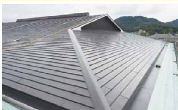
屋根施工完了状況【体育館棟】
