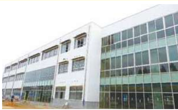
外部足場解体完了状況【校舎棟】
