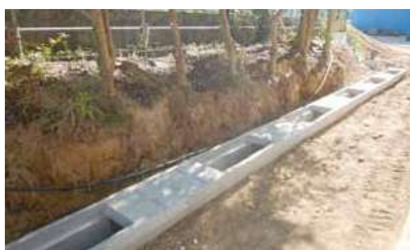
雨水排水側溝施工の様子【外構】
