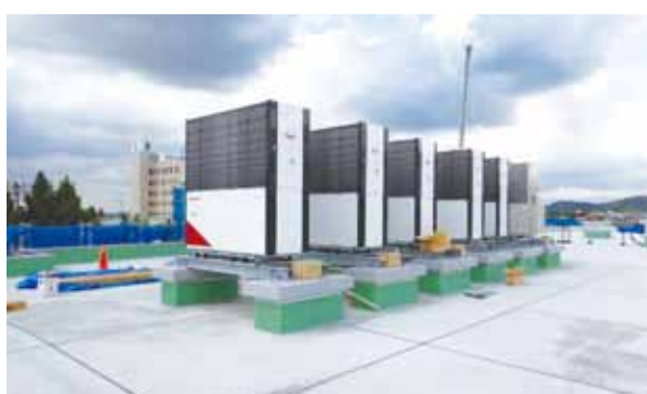
屋上機械設備据付けの様子【校舎棟】
