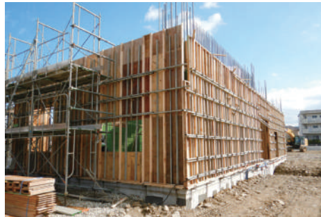
型枠工事の様子(校舎棟)
