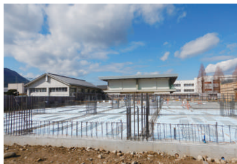
埋め戻しの様子(体育館棟)
