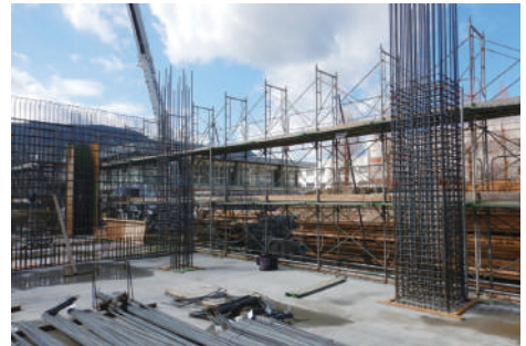
配筋工事の様子(校舎棟)
