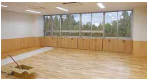
家具及びフローリング施工の様子【校舎棟】
