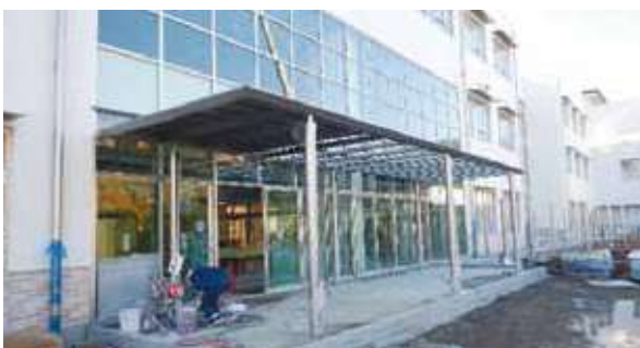
校舎棟昇降口の庇取付状況【外 構】
