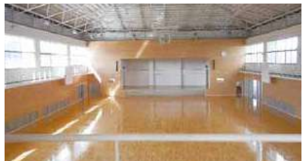
アリーナのフローリング施工後の様子【体育館棟】
