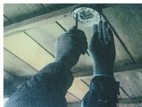
器具取り付け工事と配線工事で1台あたり約7万7千円は高い。
