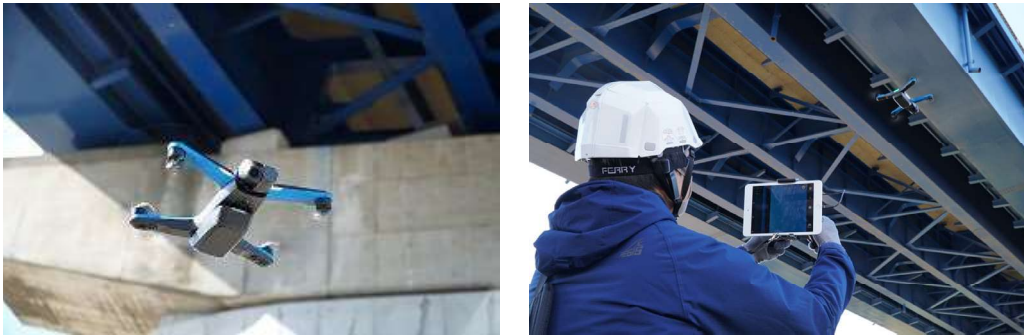
ドローンによる橋梁点検の例
