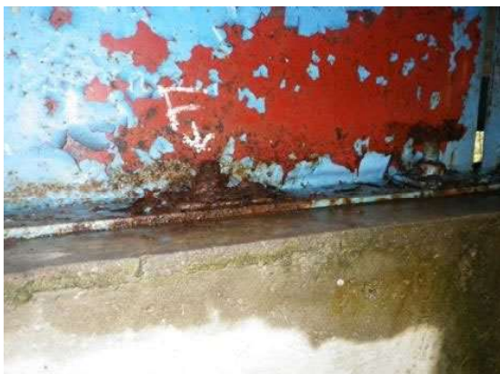
鋼材の腐食
