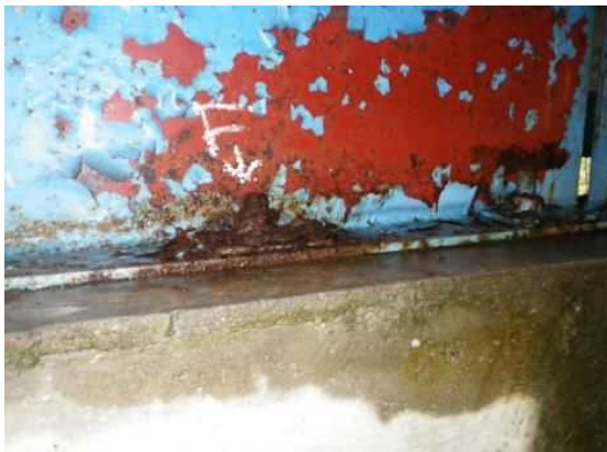
鋼材の腐食
