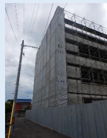
校舎棟（南）解体前足場設置状況 ※防音シート設置前
